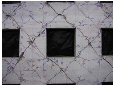
(d) Diagonal cracks at DF = \pm 5
